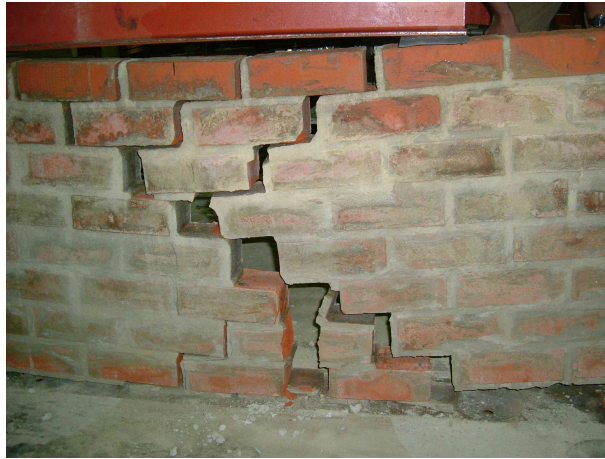
FIGURE 5.8 – Photo du mur en briques après l’essai de flexion quatre points
